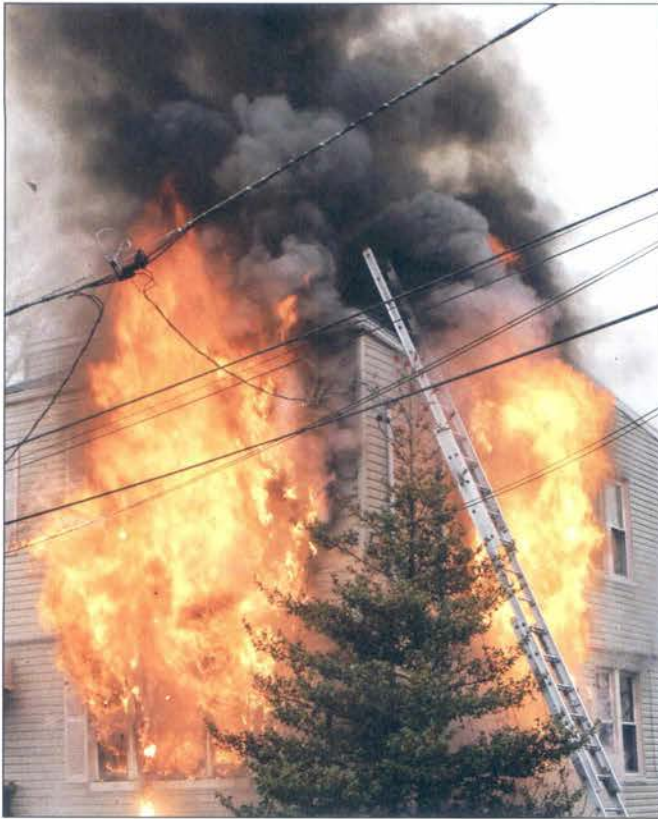
Imagen 4.53 El revestimiento de vinilo en el exterior de esta edificación proporcionó combustible para el fuego que se extendió por sus lados. Cortesía de Ron Jeffers, Union City, NJ.
