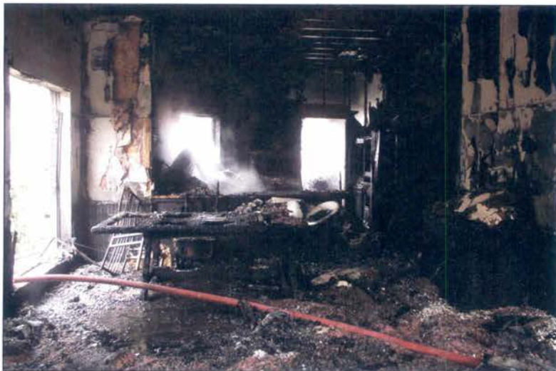
Imagen 4.44 Después de la aplicación de agua, el calor del fuego se ha reducido de modo que ya no se producirá la pirólisis del contenido y de los elementos estructurales. Cortesía de Ron Moore, Departamento de Bomberos de McKinney (TX).
