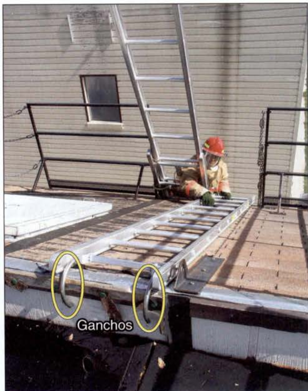
Imagen 8.4 Ganchos de una escalera de techo posicionados sobre la cumbrera de un techo.
