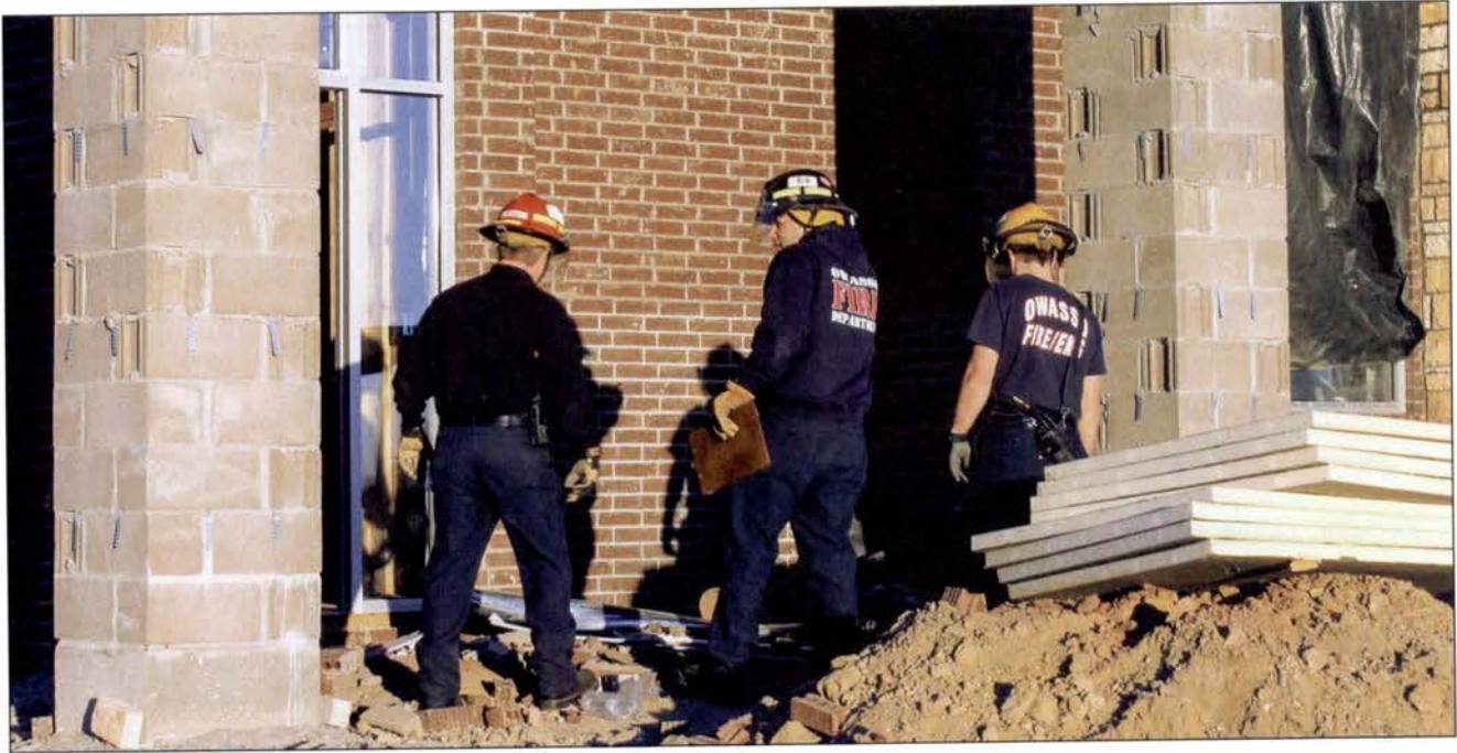
Imagen 10.20 Bomberos recorriendo una edificación en construcción.
