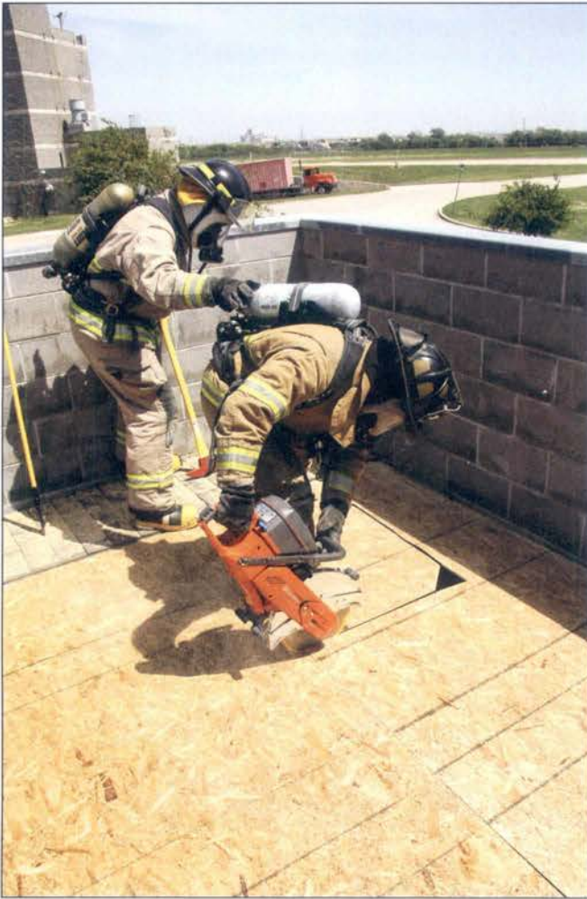
Paso 12: Haga el corte # 2: Corte el entablado del techo en un lado de la abertura paralela a los soportes e interceptando el corte # 1.
