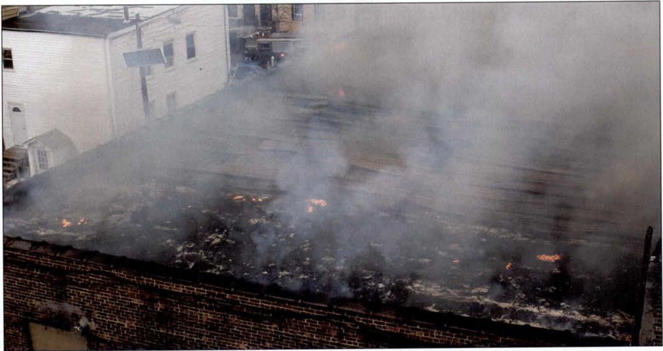
Imagen 11.12 Debido a que el fuego y el humo salen del techo, los bomberos deberían considerar la posibilidad de que este se derrumbe. Cortesía de Ron Jeffers, Union City, Nueva Jersey.
