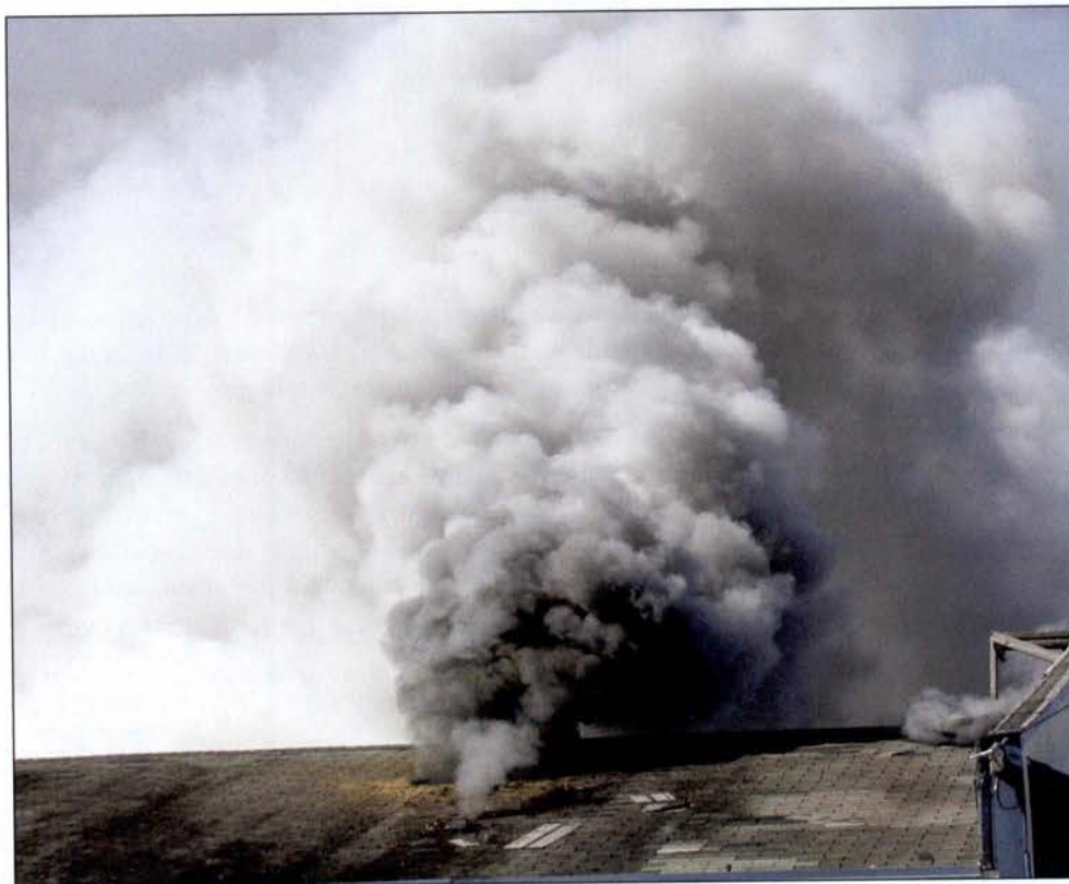
Imagen 11.7 Gases calientes y humo que salen de una estructura a través de una abertura de ventilación.
