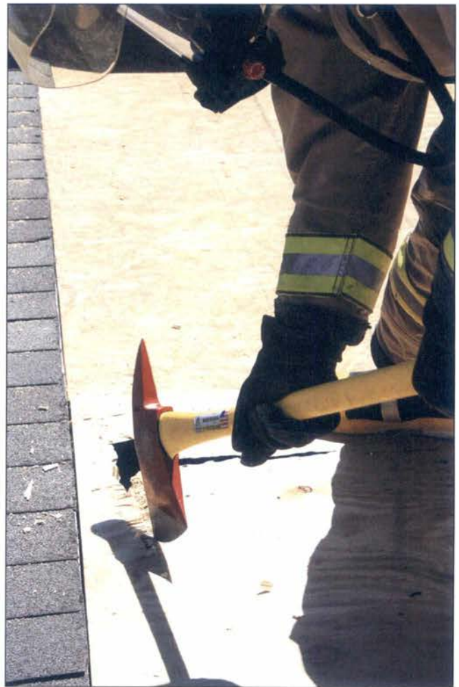
Paso 9: Realice el corte # 2: Corte el entablado del techo en un lado de la abertura paralela a los soportes e intercepte el corte # 1.
