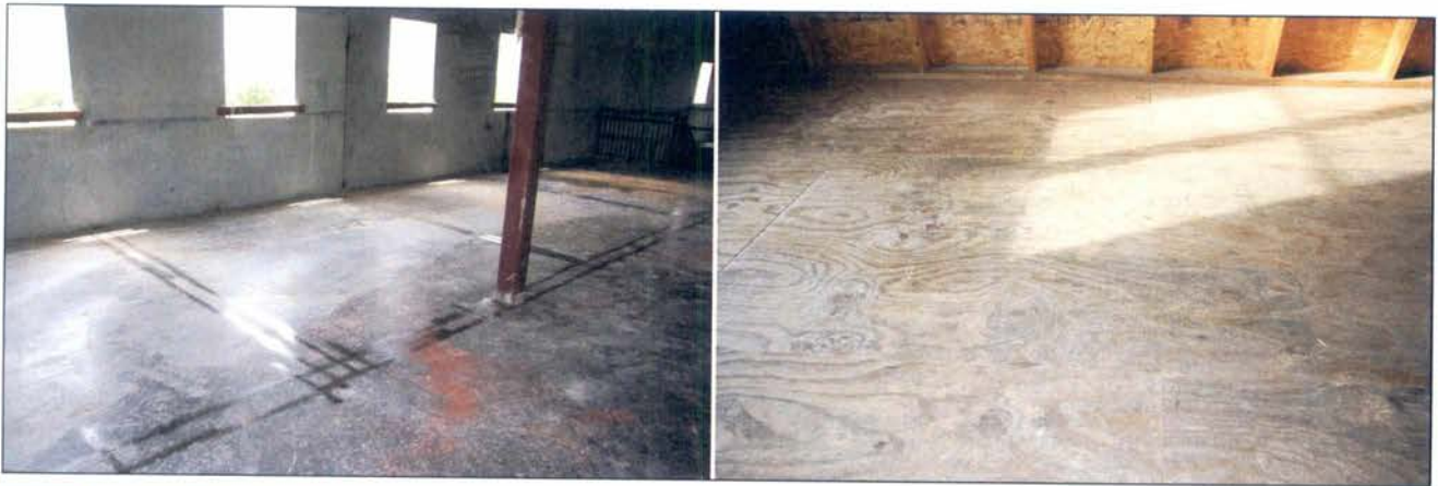
Imagen 11.38 Ejemplos de un piso de losa de concreto y un subpiso de madera.
