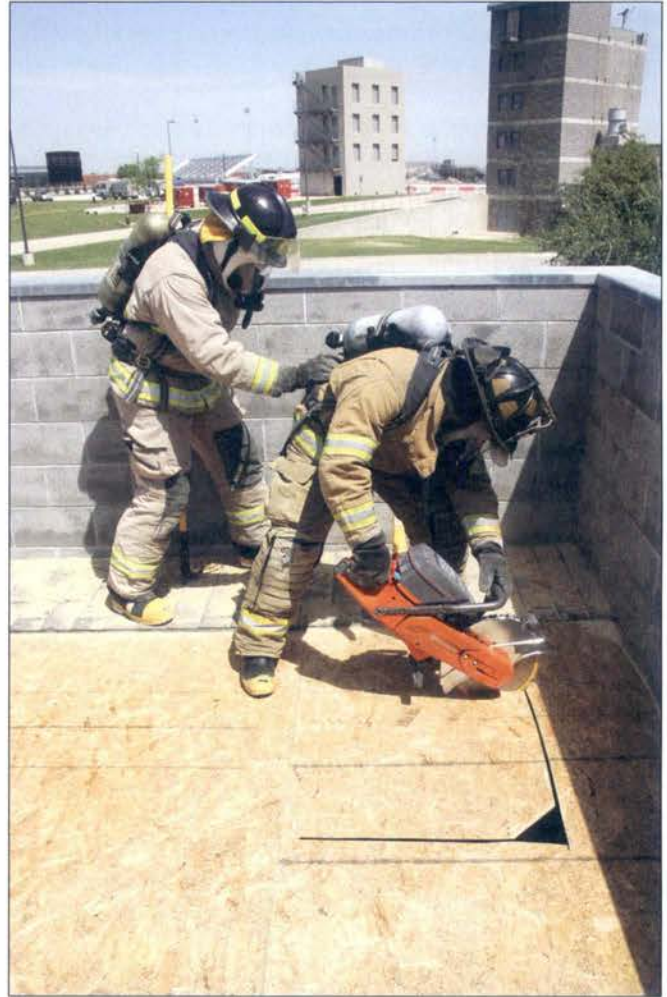
Paso 13: Haga el corte # 3: Corte el entablado del techo en el lado opuesto del corte # 2, perpendicular e interceptando el corte # 1.
