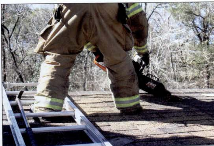
Imagen 11.33 Bombero cortando una abertura de ventilación cerca de la cumbre de un techo inclinado.
