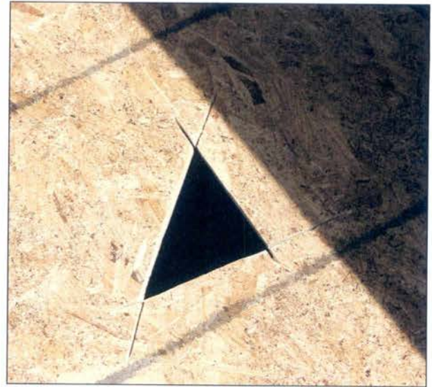
Imagen 11.31 Un corte triangular más grande puede proporcionar una mejor vista de las condiciones debajo del entablado del techo.
