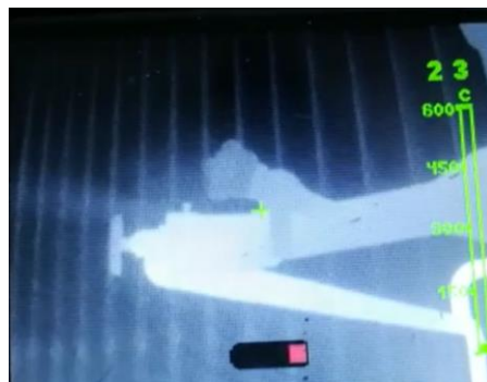
Localización de fuga de amoniaco con cámara térmica. Foto: J.M.Soriano (bombero Leganés)
