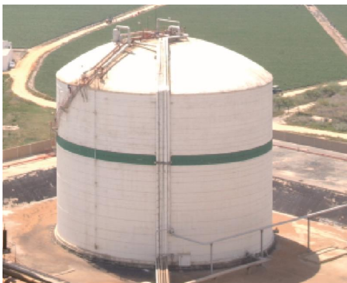
Tanque atmosférico refrigerado, de pared sencilla de acero y cubeto de tierra. Fuente: EFMA
