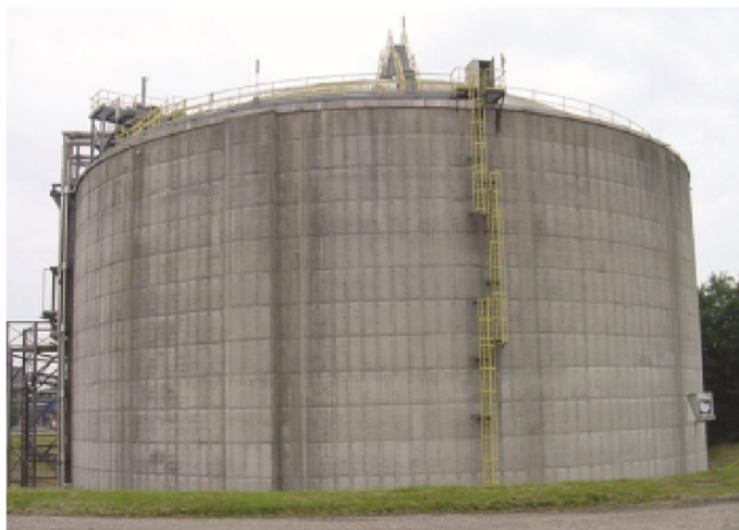
Tanque atmosférico refrigerado, de pared interior de acero, rodeado por muro de hormigón. Fuente: EFMA
