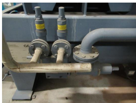
Válvula de tres vías sobre recipiente principal de amoníaco a la izquierda y en un compresor a la derecha Foto. C.Artero
