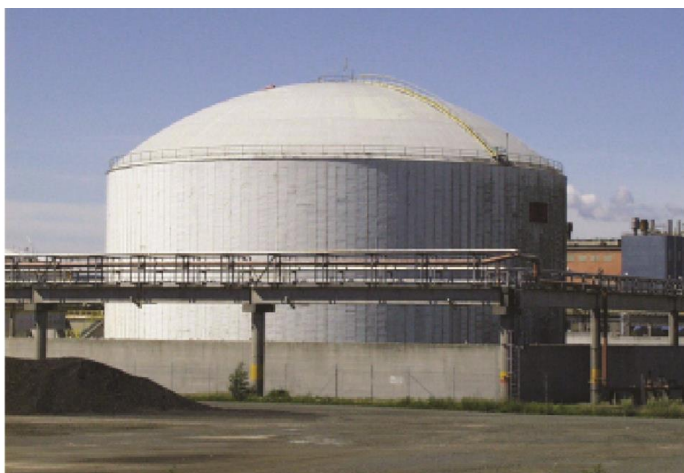
Tanque atmosférico refrigerado, de pared interior y exterior de acero, con techos separados. Fuente: EFMA
