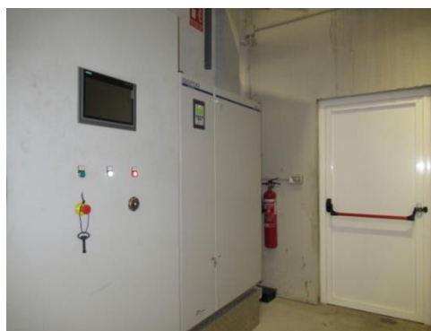
Detalle de la salida de emergencia Foto: C. Artero
