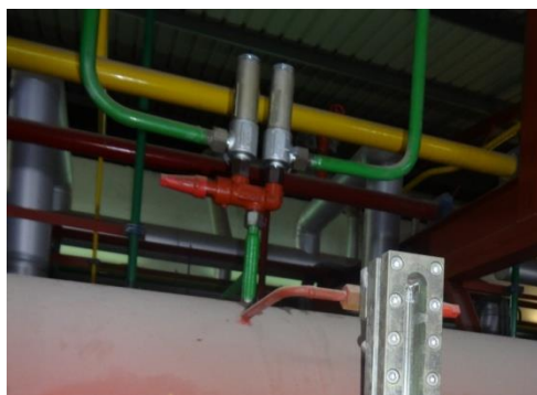
Válvula de tres vías sobre recipiente principal de amoníaco a la izquierda y en un compresor a la derecha Foto. C.Artero
